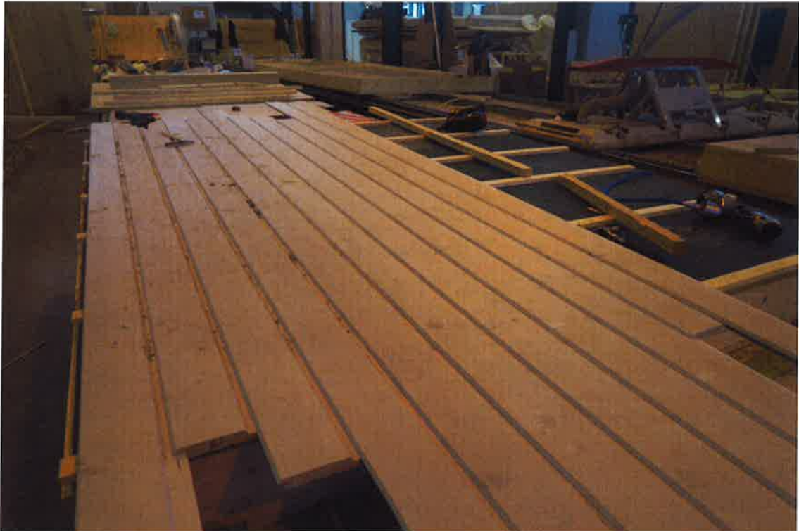
Kuva 3. Ulkoverhouksen asennus tehtaalla
