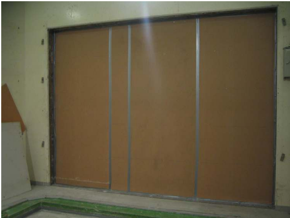
Termex Zero –ulkoseinän sisäpuoli (kipsilevy, saumat teipattuina)
