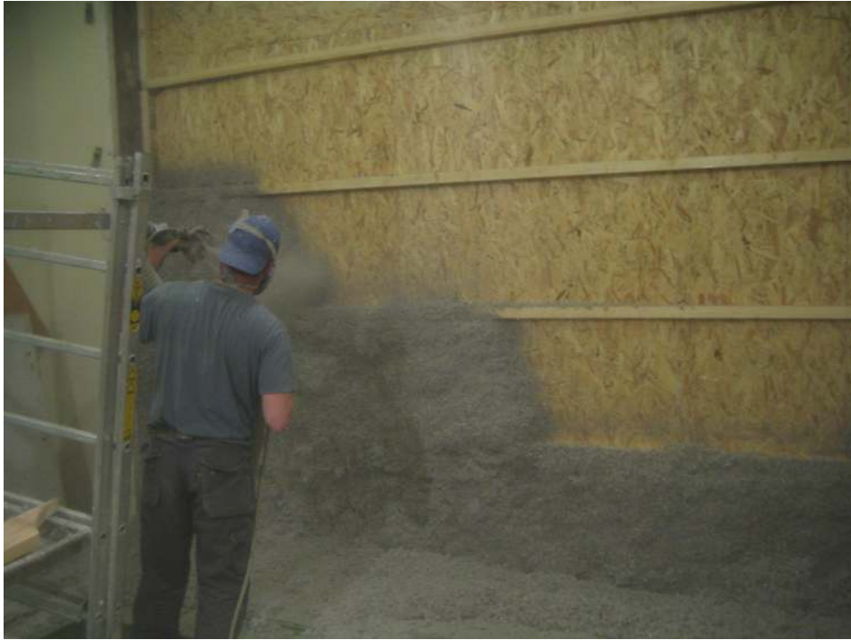
Termex Zero –ulkoseinä (lämmöneristeen lisäys sisäpuolelle)
